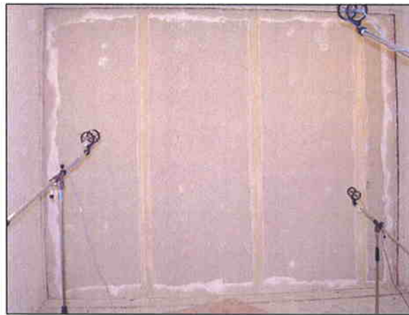
Fotografía 16 Cerramiento una vez terminado
