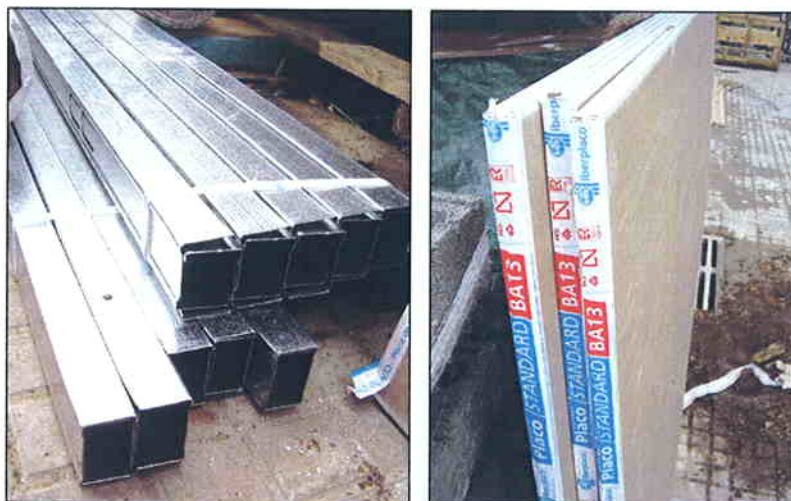
Fotografías 1 y 2 Perfiles de acero y PYL
