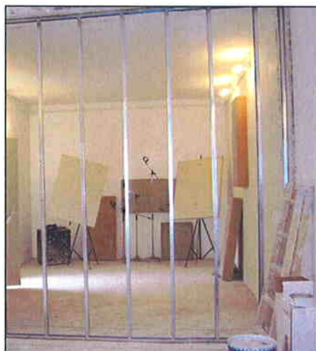
Fotografía 5 Estructura de perfiles de acero
