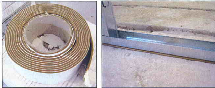
Fotografías 6 y 7 Banda Tecsound SY Band 50 y colocación entre perfiles y marco
