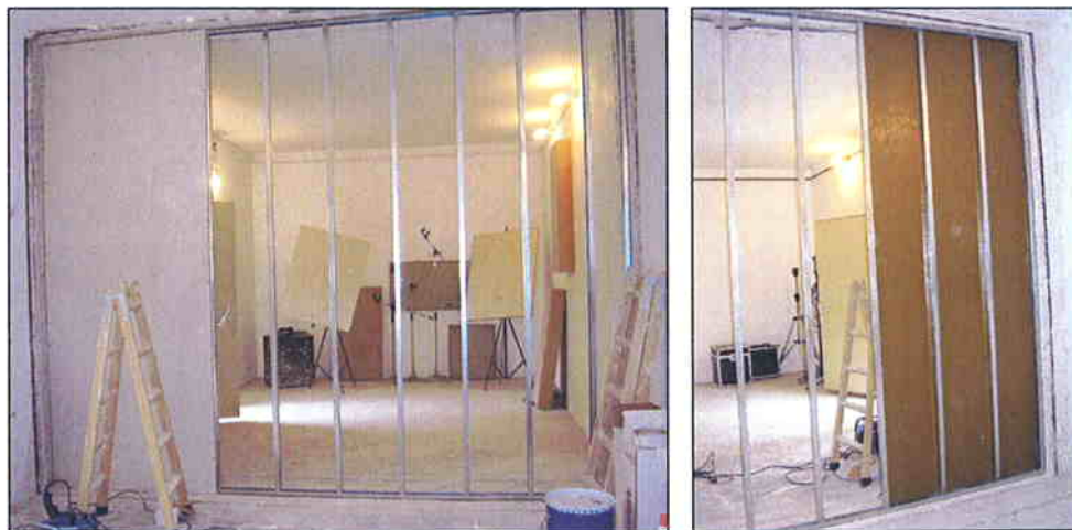
Fotografías 8 y 9 Colocación de las PYL con lámina Tecsound SY50 adherida
