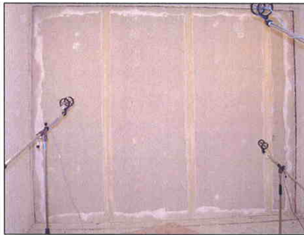
Fotografía 16 Cerramiento una vez terminado
