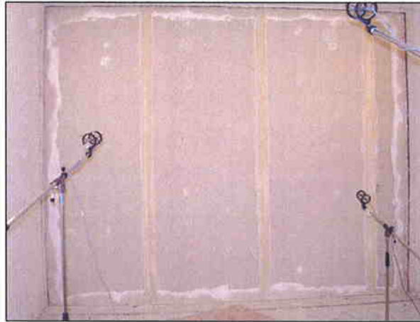
Fotografía 16 Cerramiento una vez terminado
