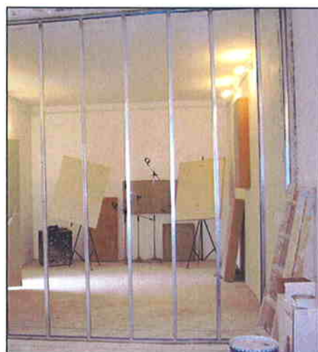
Fotografía 5 Estructura de perfiles de acero
