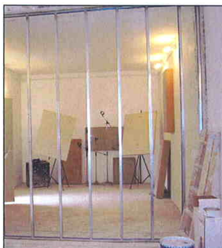
Fotografía 5 Estructura de perfiles de acero
