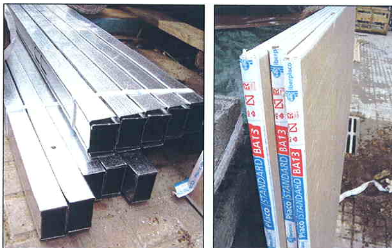
Fotografías 1 y 2 Perfiles de acero y PYL
